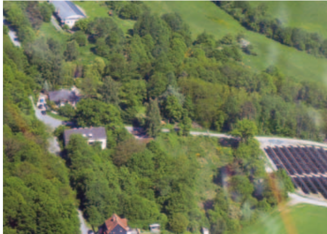
Ansicht des Geländes von Westen
